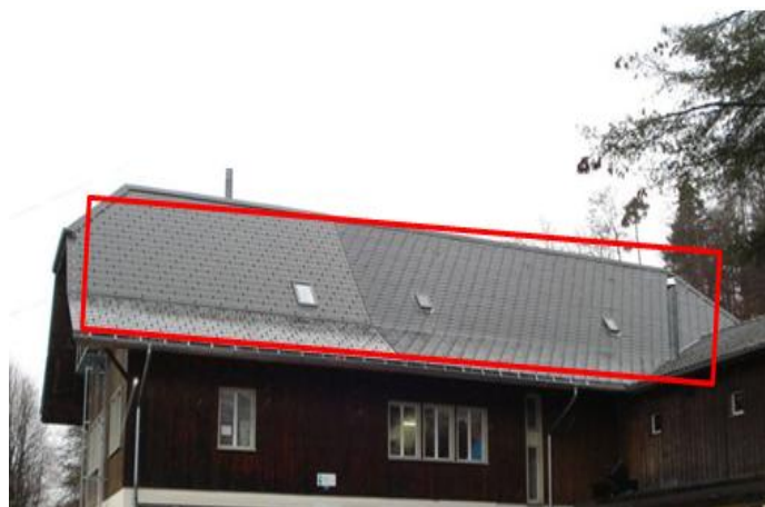
Dachfläche vor dem Umbau
