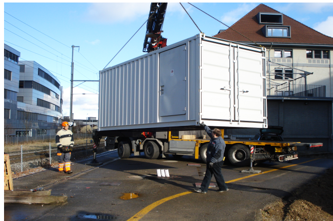
Anlieferung Diesel-Notstromaggregat 250kVA im Container
