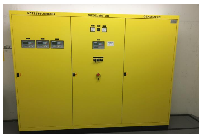
Steuerung Not-Normalnetz
