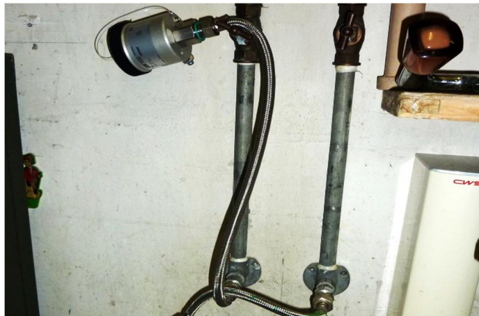
Druckmessungen am Wassernetz
