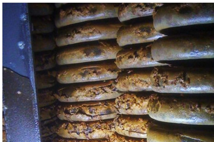
Verkalkter Boiler-Heizregister
