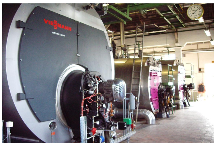
Kesselhaus - Dampfproduktion
