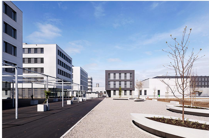
Neumatt - Kantonales Verwaltungszentrum Burgdorf PPP-Projekt mit Verwaltungsbauten, Gefängnis und Werkhof, 35'000 m 2 GF
