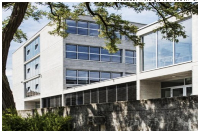
Berufsbildungszentrum Lyss Sanierung und Erweiterung Minergie-Standard, 5'000 m 2
