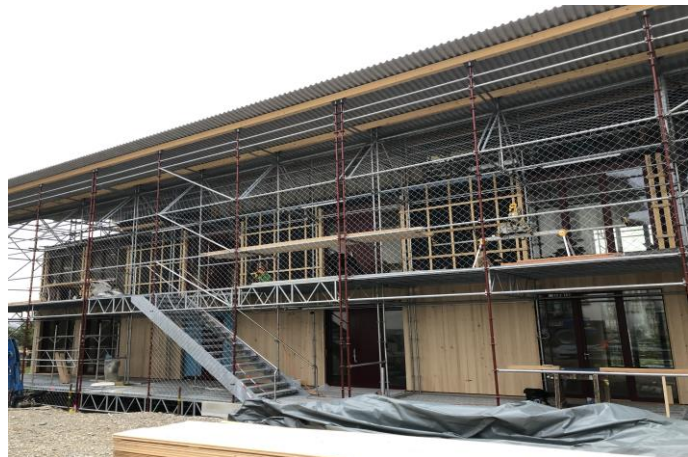
Das Gerüst dient als Erschliessung von aussen und bleibt bestehen
