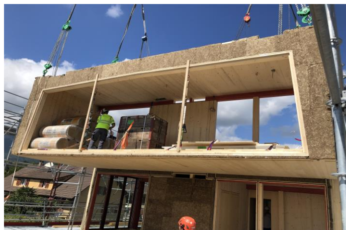
Anlieferung eines der Module
