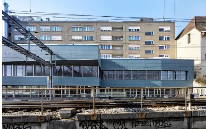
Aussenansicht des Gebäudes
