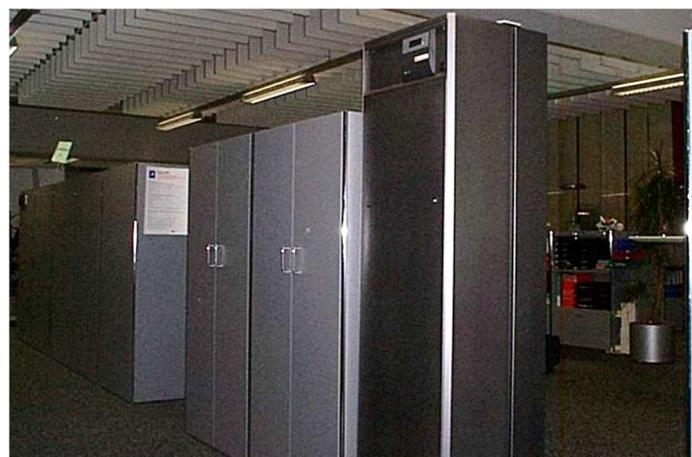
Umluftklimagerät bei einer Arbeitsinsel mit Verteilung im Doppelboden
